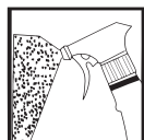
3 Umedeça as superfícies onde será feita a aplicação, com borrifadas de água limpa;
