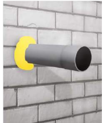
Fechamento de tubulação.
