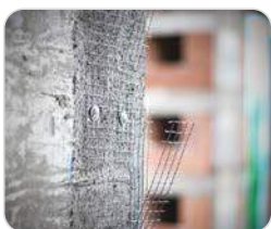
Amarração de alvenaria
