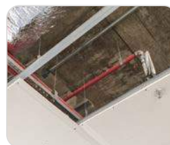
Fixação de painéis e forros
